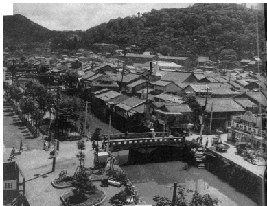
昭和30年代 常盤橋付近
